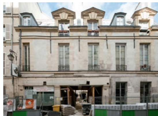
Das neue Gebäude der HCB-Stiftung in der Rue des Archives während der Umbau-Phase im März 2018.
